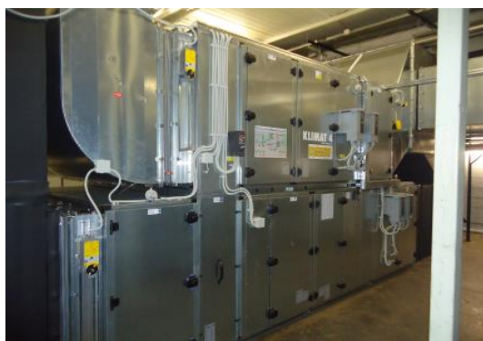
Slika 1: Prenovljen klimat v stavbi Hale 1.
